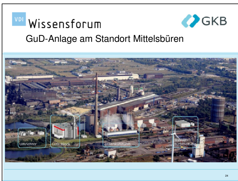
Bild 4: GuD-Anlage am Standort Mittelsbüren
